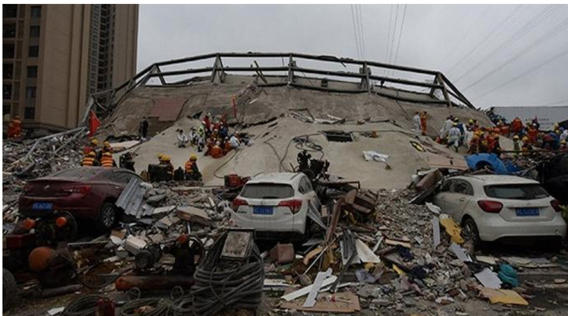
某酒店整体坍塌造成29人死亡
