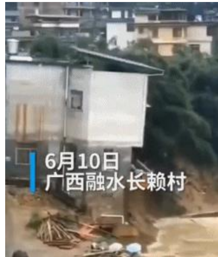
河水冲刷导致房屋整体倾覆
