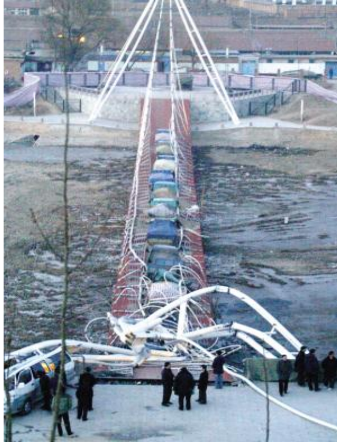
悬索桥垮塌—桥塔失稳 钢结构通廊垮塌—整体失稳
