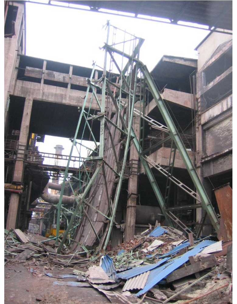
悬索桥垮塌—桥塔失稳 钢结构通廊垮塌—整体失稳
