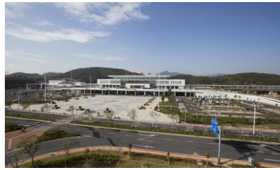
漳平西站站前广场及通站道路工程
