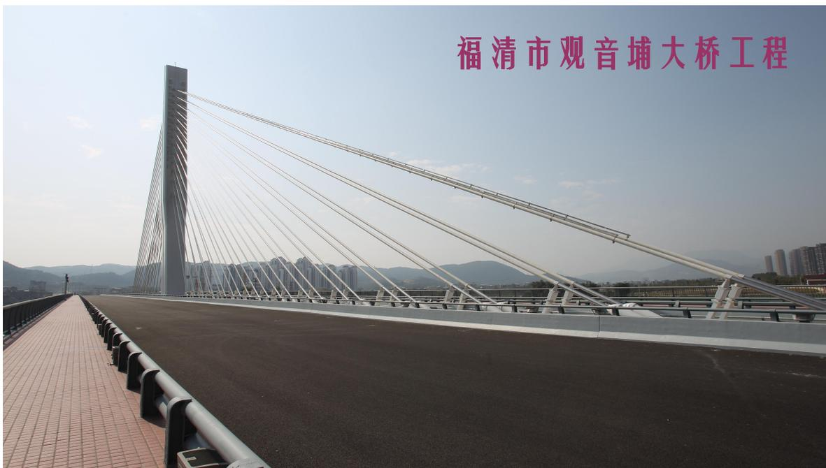
福清市观音埔大桥是福清市城区重要的南北向交通干道，大跨度主桥采用斜独塔斜拉桥方案，主桥结构为塔、墩、梁固结体系；桥体结构采用预应力混凝土连续箱梁结构。
