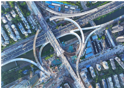
武汉市友谊大道高架桥钢箱梁工程
