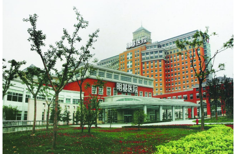
南京明基医院装饰工程
