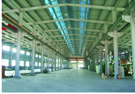
福鼎秦屿工业区钢结构厂房
