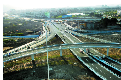
福建泉州市政工程
