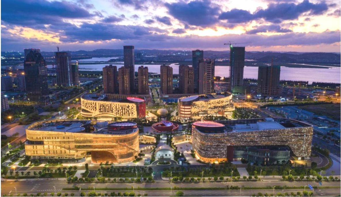
泉州市公共文化中心工程位于泉州市丰泽区东海片区,综合大道与景观西路交汇处,项目建设包括科技与规划馆、工人文化宫、图书馆、大剧院等四座文化建筑及商业配套工程,工程总建筑面积 339616 m<sup>2</sup>,其中地上建筑面积 139065 m<sup>2</sup>,地下建筑面积 200551 m<sup>2</sup>;地下 2 层,地上 6~8 层,建筑高度 37.15 m。
