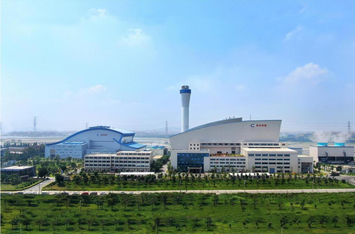
莆田市生活垃圾焚烧发电厂三期扩建项目位于莆田市秀屿区东庄镇锦山村胜利围垦内，建设规模为 1800 t/d 垃圾焚烧炉，配 30 MW 凝汽式汽轮发电机组，厂区建筑面积 36600 m<sup>2</sup>。
