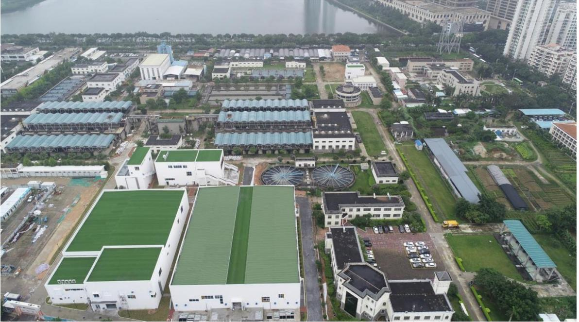
筓筓污水处理厂位于厦门市思明区湖滨西路 89 号。筓筓污水处理厂三期工程是在现状筓筓污水处理厂出水水质的基础上,新建二级提升泵房、后置反硝化滤池、高速气浮池、消毒设施等深度处理设施进一步提升水质净化效果,达到一级 A 标准。工程总建筑面积 9057m<sup>2</sup>,建设规模日处理 30 万吨。
