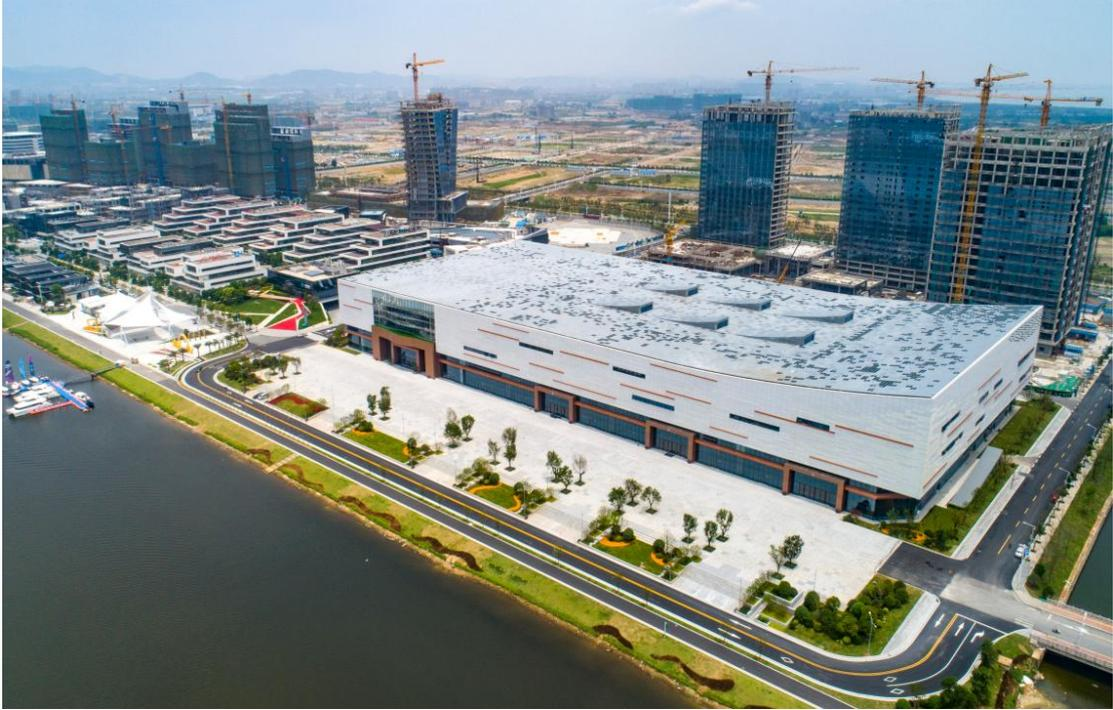
福州数字中国会展中心工程位于福州滨海新城东湖路东侧、智慧路南侧，项目是一栋集绿色、智能、环保为一体的大型建筑场馆，主要功能为主会议厅、数字展厅、高端会议室(可满足 100 人超大型领导人圆桌会议)、分论坛会议室及会议配套功能用房。工程规划用地面积 66.60 亩，总建筑面积为 115903.4 m<sup>2</sup>，其中地上建筑面积 84998.84 m<sup>2</sup>，地下建筑面积 30904.56 m<sup>2</sup>，地下一层、地上 3 层。
