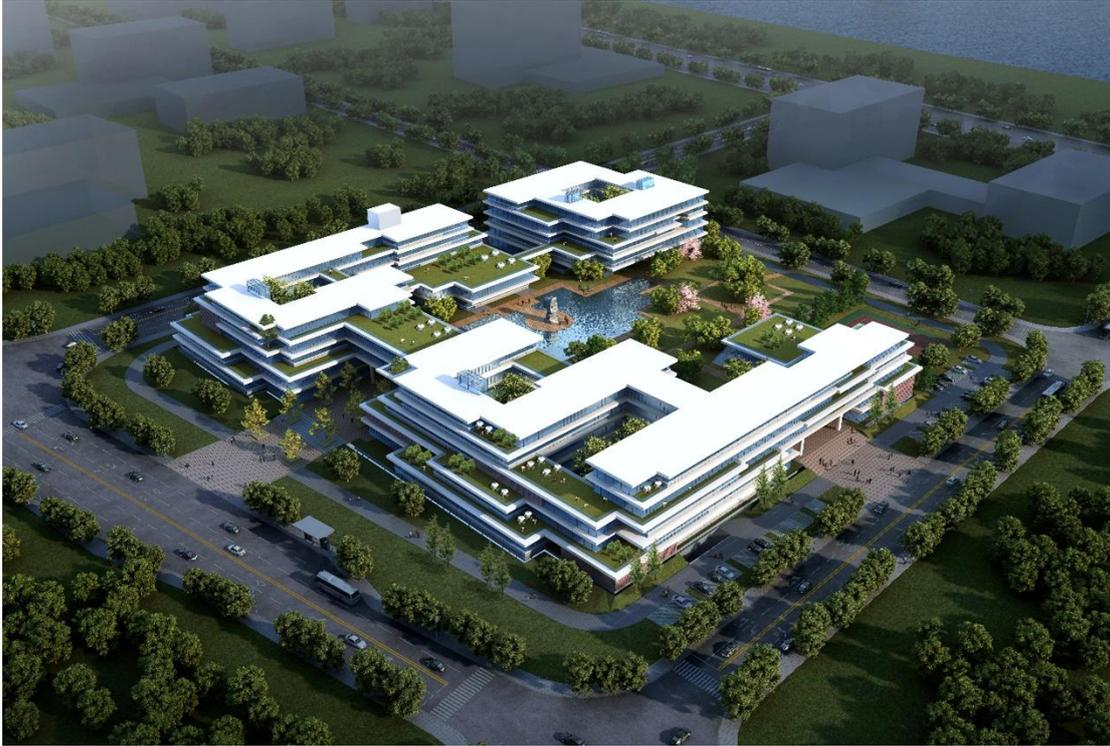
国家知识产权局专利局专利审查协作北京中心福建分中心技术用房工程位于福州海西高新技术产业园内，为综合办公楼，福建省重点工程项目。工程总建筑面积为 62989m<sup>2</sup>，其中上部 5 层面积为 49998m<sup>2</sup>，地下一层面积为 12991m<sup>2</sup>，建筑高度为 23.9m。地下一层为双层机械停车库、综合球馆、设备用房等；一层为门厅、综合测试室、测试室、厨房、食堂、报告厅、设备用房、消控室等；二~五层为综合测试室、测试室、信息机房、活动室、休息室、辅助用房等。
