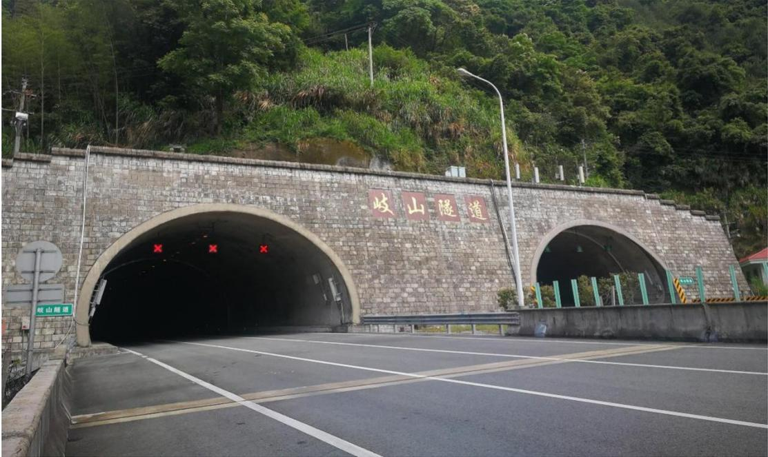
湄洲湾至重庆高速公路莆田段岐山隧道位于福建省莆田市仙游县游洋镇，隧道左线全长 8039m，右线全长 8044m，为当时全国最长的双向六车道高速公路特长隧道。隧道设通风竖井两座（深 266m 和 277m），11 处紧急停车带、11 处车行横通道、22 处人行横通道。隧道单洞净高 7.9m，净宽 15.2m，设计时速 100Km/h，设计使用年限 100 年。
